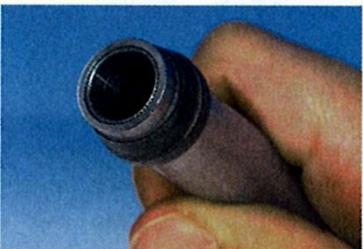
Die Verstärkungshülse sitzt fest und stützt das Rohr vor Einschnürung bei der Montage.
